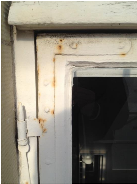
Rust på metaldel Øverst "bundliste" revnet med vandindtrængen
