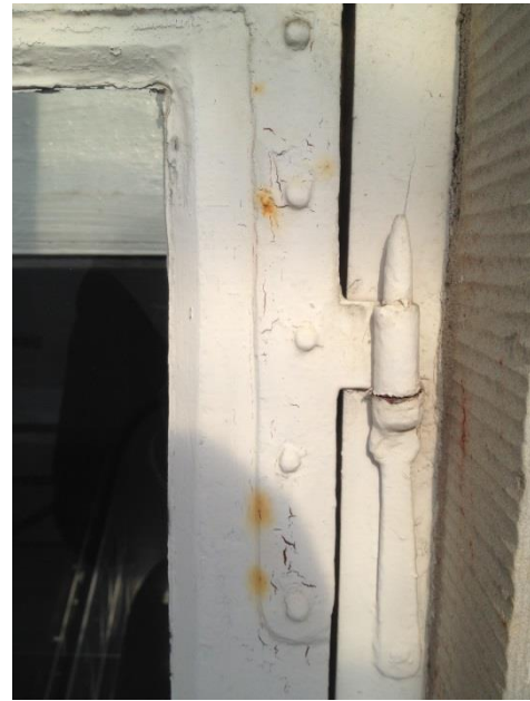
Rust på metaldel samt "krybning" af maling - muligvis grundet afrensning utilstrækkeligt
