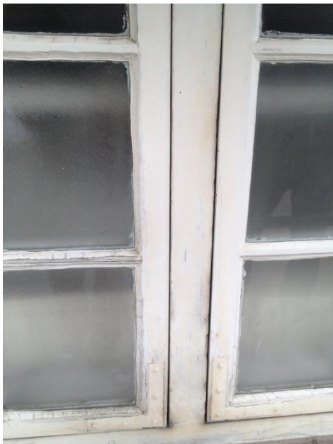
Glaslister defekt og revnet. Kitfals defekt og revnet Forvitring af overflade.
