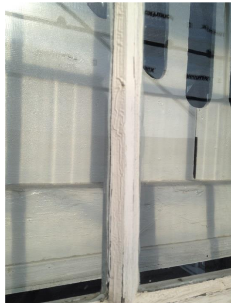
Krybning af maling på ramme defekt malingfalde
