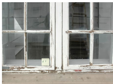
Udsnit af vinduesfag under registreringen i 2014 efter afrensning.
