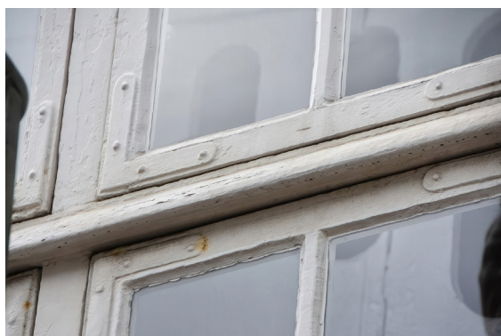
Udsnit af vinduesfag. Fotograferet ved besigtigelsen i september 2024.
