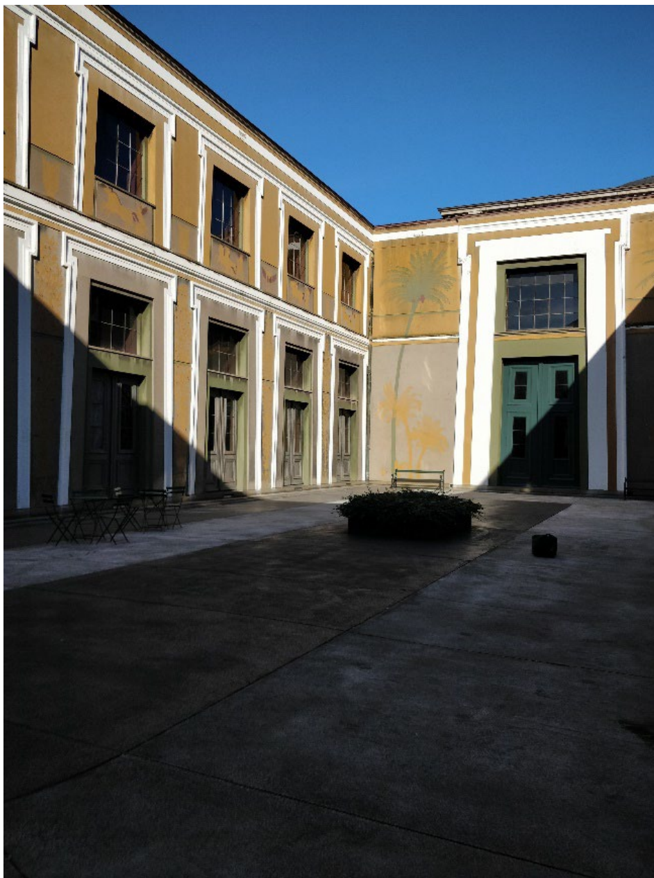
Fig. 5. Atriumgården marts 2022. Malingslag på både vinduer og døre er meget nedbrudte. De to porte er indenfor den seneste årrække, uafhængigt af hinanden, blevet malet i hver deres grønne farvenuance.
