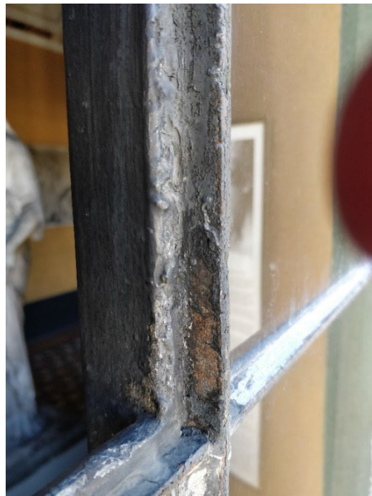
Fig. 12. Derpå følger flere lag af mørkegrå grafitholdig oliemaling. Grafitalmalingen er i stort omfang "vasket/-brændt" af kittet af vejrliget, og den er kun bevaret på de yderste tynde jernprofiler og i vinduesfalsen.
