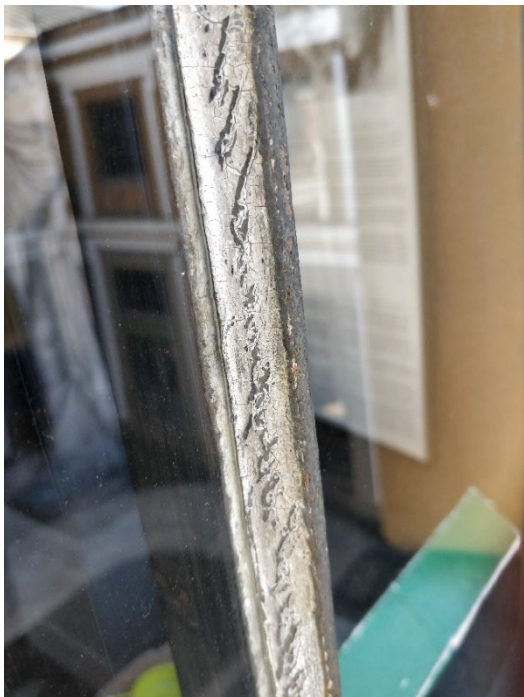
Fig. 11. Vindueskit og vinduesrammer har muligvis fra begyndelsen været bundbehandlet med en zinkhvidt holdig oliemaling tilsat lidt blyhvidt?.
