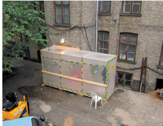
3-kammer-sluse med adskillelse af ren og beskyttet zone
