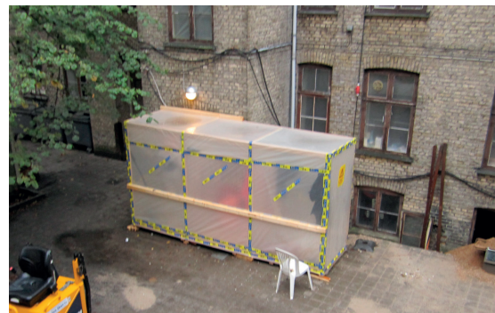
3-kammer-sluse med adskillelse af ren og beskyttet zone
