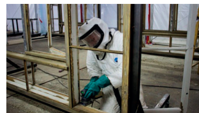
Afrensning af vinduer i telt. Hele teltet er med undertryk, sluseadgang og blyzone
