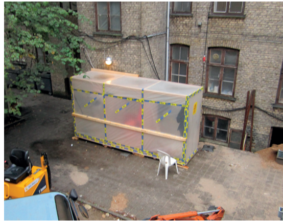
3-kammer-sluse med adskillelse af ren og beskidt zone
